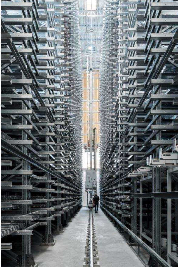
Magazzino Automatico Verticale
